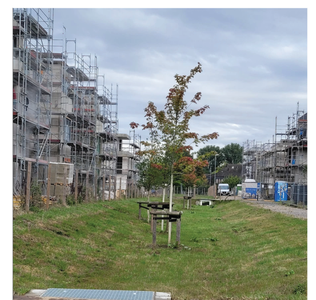
Beispiel -> Entwässerung in flachen Mulden (Duisburg)
