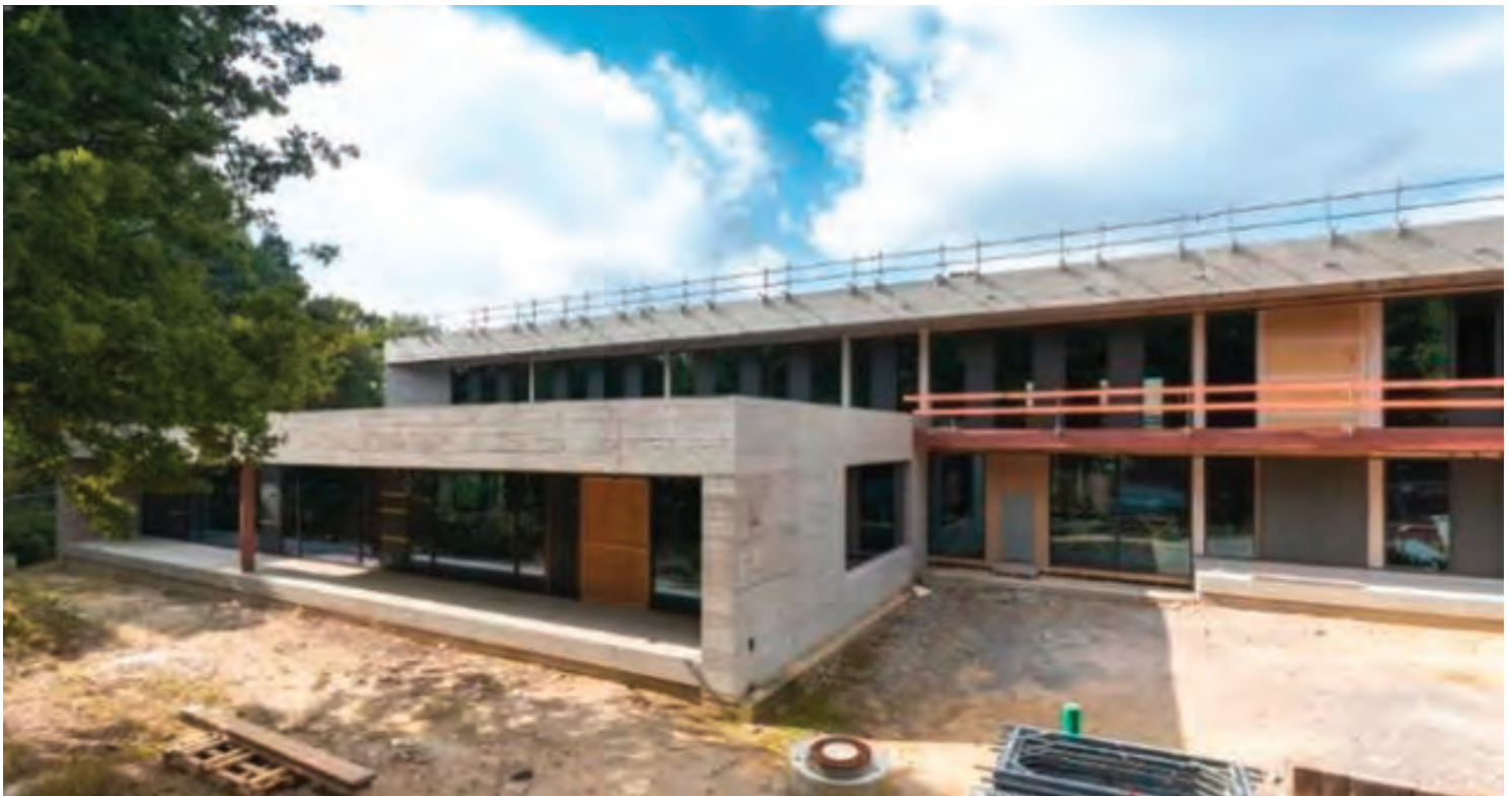
Abbildung 50: Grundschulneubau Kinderhaus - Im Bau; https://www.stadt-muenster.de/immobilien/bauen/bauprojekte/grundschule-schulzentrum-kinderhaus .
