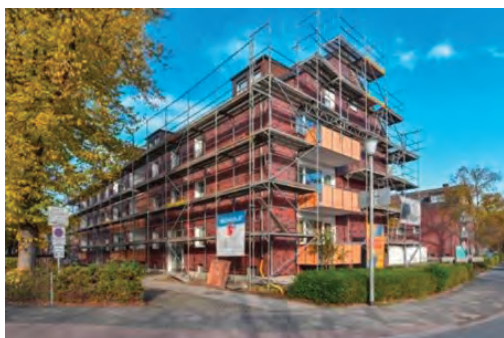
Abbildung 34: Energetische Sanierung im Bestand; Foto: Stadt Münster.
