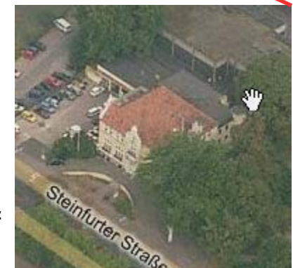
Schützenhof (ehem. Offizierskasino)
