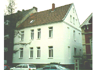
Sanierungsobjekt Heerdestraße Münster - vor und nach der Sanierung
