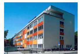
Sanierung Hafenstr. Wohn+ Stadtbau
