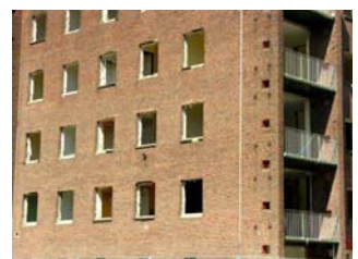
Abriss und Sanierung des Bestandes in Holtenbroek www.nieuwholtenbroek.nl
