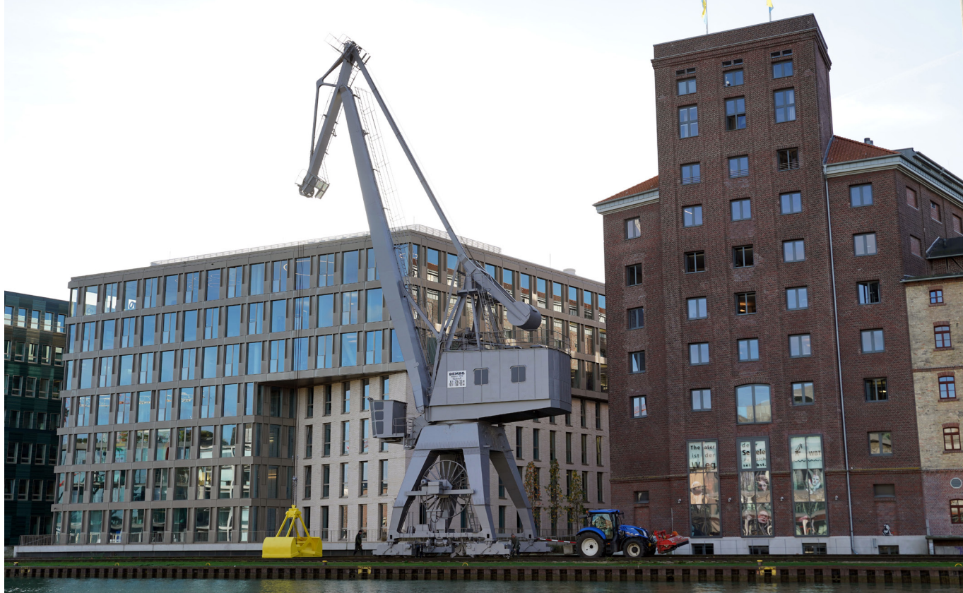
Blick auf den sanierten Rhenus-Kran. Foto: Stadt Münster
