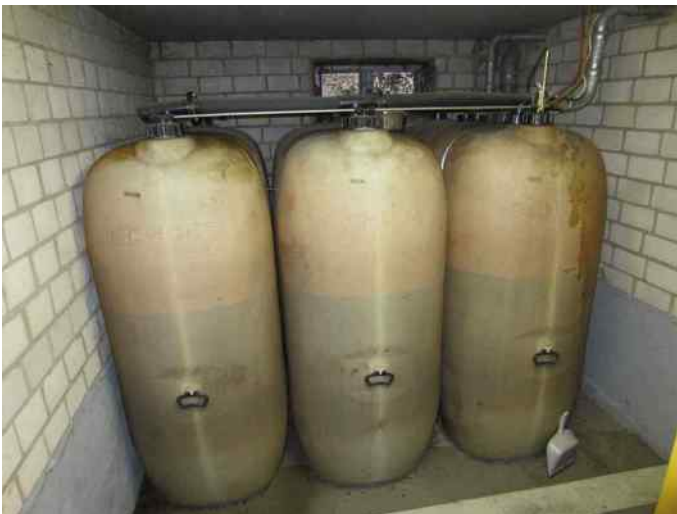
Nicht einsehbarer Auffangbereich
