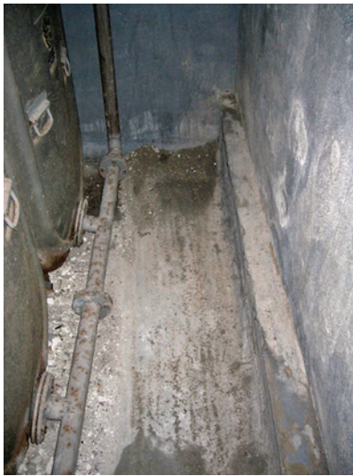
Defekte Beschichtung
