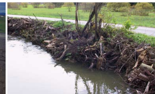
Der Einbau der Weidenspreitlagen dient der Ufersicherung. Die ineinander verzahnten Wurzelstöcke stellen eine sehr naturnahe Bauweise dar. Sie sichern das Ufer, bieten Fischen Unterstandsmöglichkeiten und können mit Erlen und Weiden hinterpflanzt werden, um einen dauerhaften Schutz zu gewährleisten.
