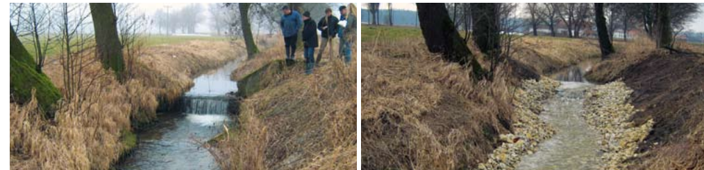
Im Rahmen eines Gewässerentwicklungskonzeptes wurden in diesem Bach sechs Sohlabstürze in flache und biologisch durchgängige Sohlrampen umgebaut.
