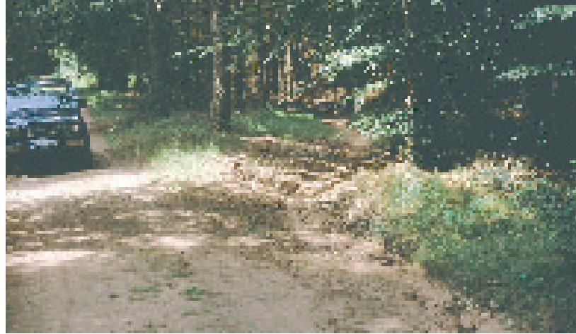
Wasser sollte vom Wegekörper zwar weggeleitet, aber in der angrenzenden Waldfläche wieder versickert werden.
