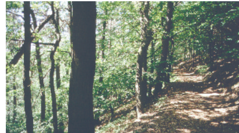
Über das Quergefälle des Weges kann Oberflächenwasser breitflächig im Wald verteilt werden.
