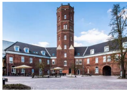
ALEXIANER HOTEL AM WASSERTURM
