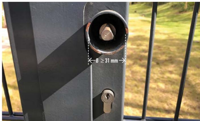
Für die Ausführung der Verschlusseinrichtung sind sämtliche angegebene Maße des Dreikanteinsatzes zu berücksichtigen. Insbesondere der Öffnungsdurchmesser von 30 mm darf bei der Verschlusseinrichtung in keinem Fall unterschritten werden.
